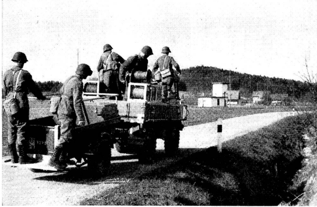
Die sorgfältige Beurteilung des Geländes durch den Fahrer eines Baufahrzeuges und entsprechend zweckmässiges Fahren des Unimogs tragen dazu bei, der Baugruppe die Arbeit zu erleichtern.
