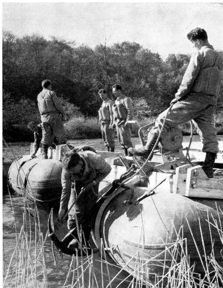
*Zur Zeit sind Versuche mit einer 50 t schwimmenden Brücke im Gange. Sie kann aus den fertigen Elementen in einer halben Stunde zusammengesetzt und noch schneller abgebaut werden, was wichtig ist, da auch unsere Genietruppen die Erfordernisse des Atomkrieges «schnell auftauchen und schnell verschwinden» zu berücksichtigen haben.*
