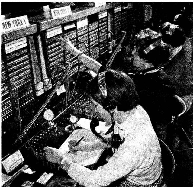
Blick auf eine Reihe von Terminalbuchten. Im Hintergrund zwei Buchten Empfangs-Vogads für automatische Sprachverstärkung
