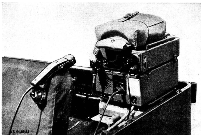
Das Gewicht des kompletten Kleinfunkgerätes beträgt 11,3 kg. Die Speisung des Kleinfunkgerätes kann auch durch den Handgenerator erfolgen, wobei dieses nachschubfrei eingesetzt werden kann. Mittels Handgenerator wird gegenüber dem Trockenbatteriebetrieb eine dreimal grössere Sendeleistung erzeugt.
