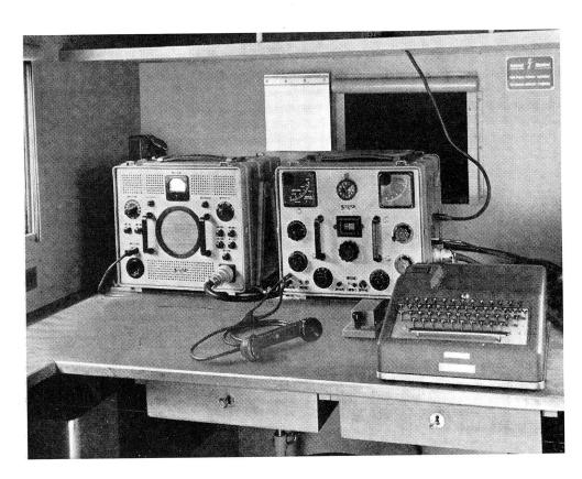
Fig. 11. Funkstation SE 222 mit ETK-Fernschreiber in Motorfahrzeug eingebaut.
