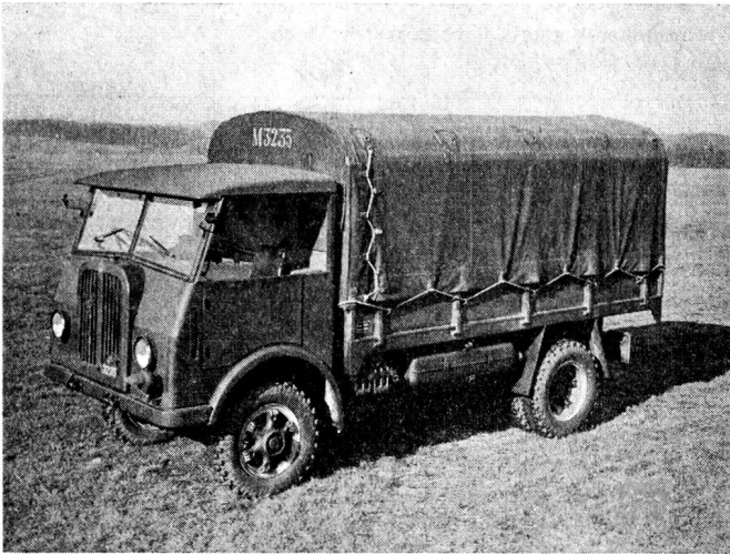
Abb. 2 Geländelastwagen 3 1/2 t — 4x4, Saurer Dieselmotor, Nutzlast 3 1/2 t
