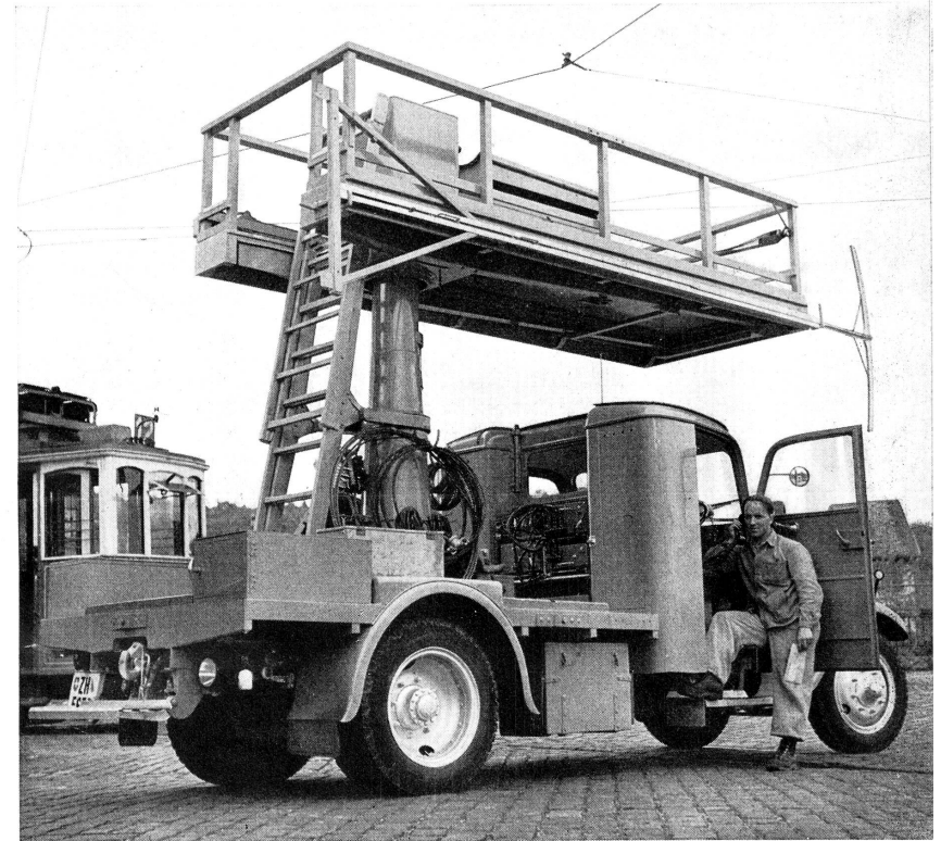
Vollautomatische Radiovoxanlage der Industriellen Betriebe der Stadt Zürich Turmwagen der VBZ. Antennenstab auf der Kabine, Apparatur an der Rückwand und Sprechstelle am Armaturenbrett.
