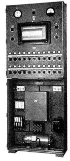
Tonfrequenz-Generator und Kopplungseinrichtung für ein Niederspannungsnetz
