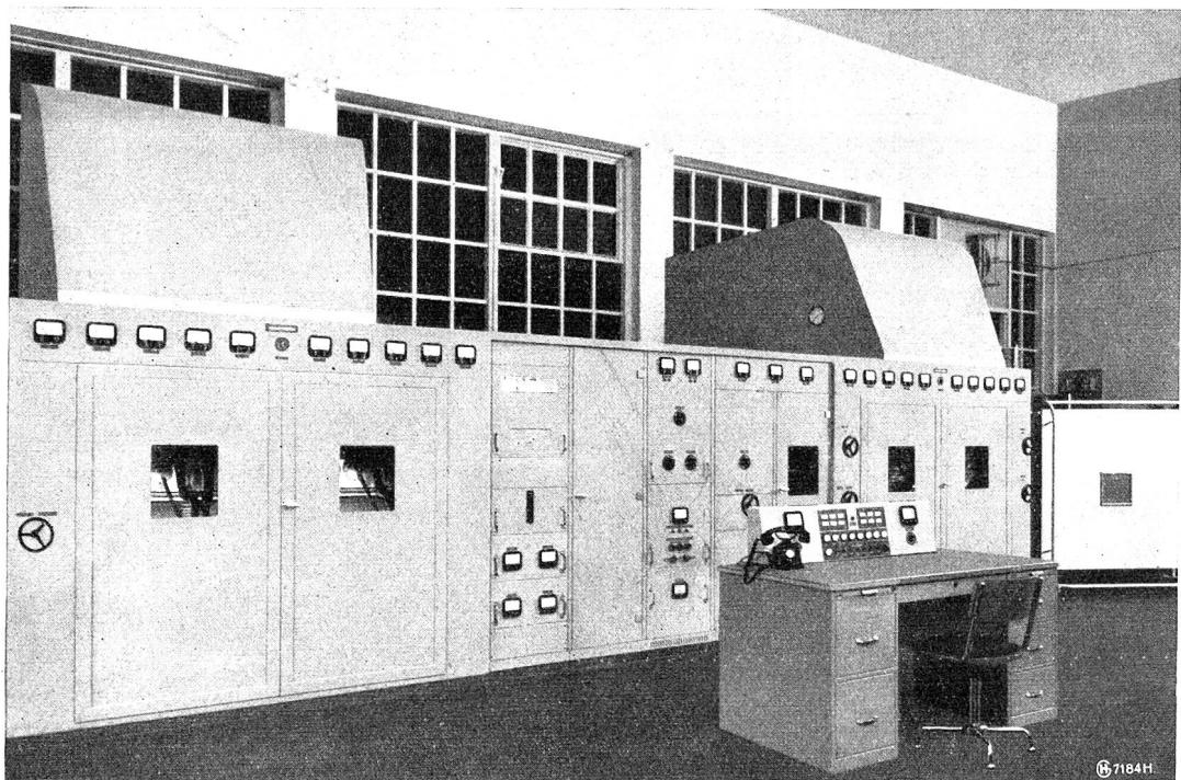
wurde als Rundspruchsender mit einer Leistung von 50 / 100 kW für das Mittelwellenband von 550 ... 1550 kHz gebaut und dabei erstmals der von der **Hasler AG** entwickelte Kathodenverstärker verwendet. Diese Neukonstruktion ermöglicht, mit einer nur 300 W Anodenverlust aufweisenden Röhre die grosse Endröhre mit 20 kW Anodenverlust praktisch verzerrungsfrei auszusteuern.
