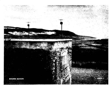
Drahtlose Telephonie, Fernmess- und Fernsteueranlage für die Wasserversorgung der Gemeinde Yverdon. Die Uebertragung ist mit einfachen Dezimeterwellenfunkgeräten zwischen Reservoir, Pumpstation und Ueberwachungsstelle möglich. Auf dem Dach des Reservoirs sind die aufgebauten Richtantennen zu erkennen.
