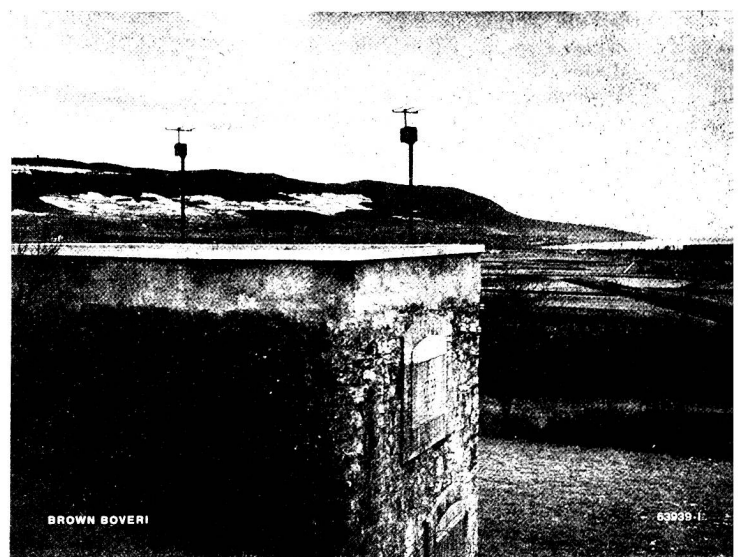
Drahtlose Telephonie, Fernmess- und Fernsteueranlage für die Wasserversorgung der Gemeinde Yverdon. Die Übertragung ist mit einfachen Dezimeterwellenfunkgeräten zwischen Reservoir, Pumpstation und Überwachungsstelle möglich. Auf dem Dach des Reservoirs sind die aufgebauten Richtantennen zu erkennen.
