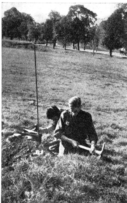
Bild 1. Bereits vorhandene Deckung ausnützend, wird fleissig weitergearbeitet. Auf dem Erdwall liegt der griffbereite Spaten; Funkerpioniere im wahrsten Sinn des Wortes.
