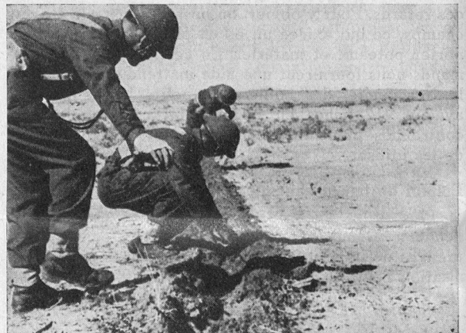
Kgl.-englisches Korps der Uebermittlungstruppen. Das Kabel wird in den neu ausgehobenen Graben gelegt.
