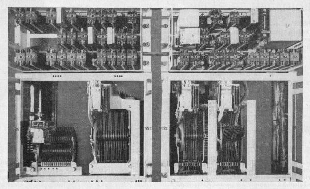
Tandemstromkreis. Links: Tandemwähler für  $2\times 50$ , ausbaubar auf  $3\times 50$  Ausgänge. Mitte: Verstärkeranschaltsucher. Rechts: Markierschalter für Tandemsucher. Unten: die zugehörigen Relais.
