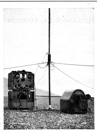
Tragbare leichte Sende-Empfangsstation mit benzinelektr. Aggregat
