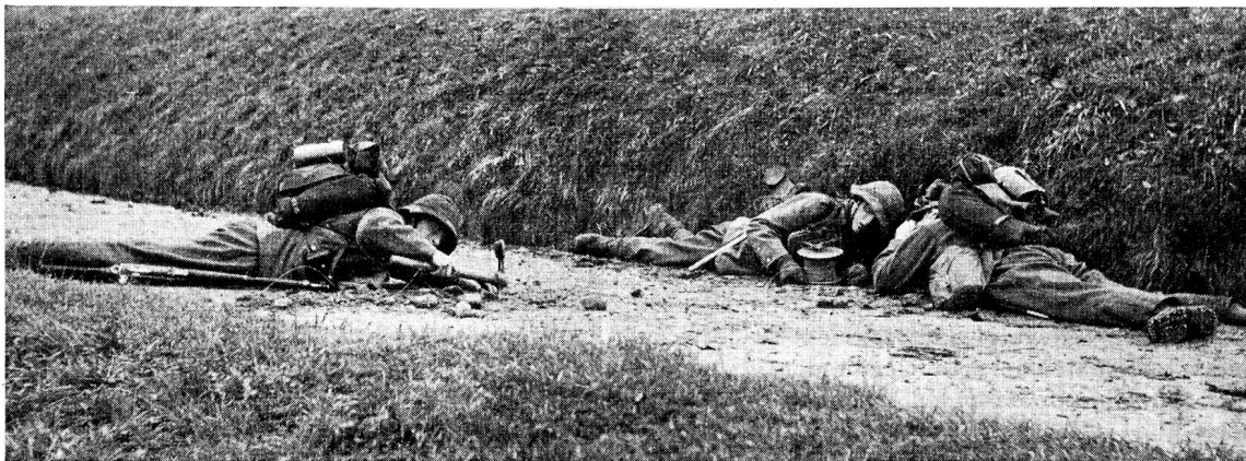
Die Aufgabe des Telephonsoldaten beim Leitungsbau ist hart. Hier pickelt er eine Furche in den Strassenboden, in der das Kabel die Feldstrasse kreuzt.
