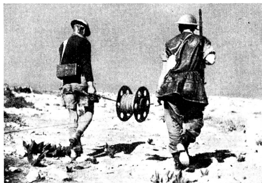
Britische Telephonsoldaten beim Legen einer Leitung in der Wüste
