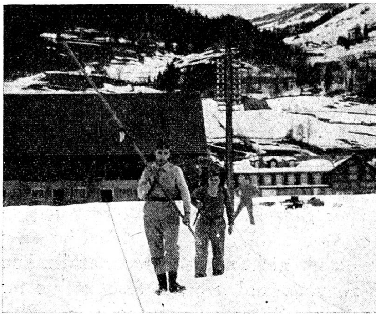
Kabellinienbau für das Slalomrennen Hegmatt—Engelberg.
