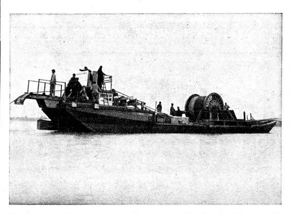
Verlegung eines Telephonkabels von 2620 m (in einer Länge) und 30 t Bruttogewicht durch den obern Zürichsee zwischen Rapperswil und Lidwil (Schwyz) - Etzelwerk - für die Schweizerischen Bundesbahnen. 17. August 1937. Verlegeschiff in voller Fahrt.
