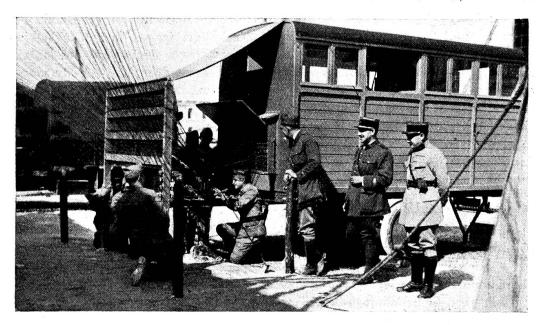
Wirrwarr ankommenden Drähte werden auf einen Drahtführungsverteiler gesammelt und kommen dann geordnet an den permanenten des Stationswagens. Dieser letztere ist als Anhänger eines Lastwagens konstruiert und hat Pneubereifung. Die Mannschaft ist mit dem Einschalten der Drähte beschäftigt.
