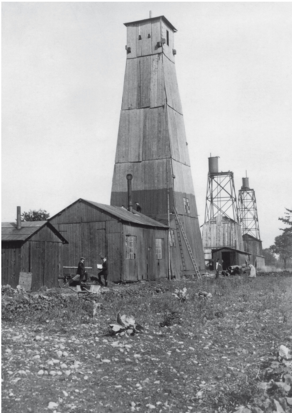
Tours de forage et de pompage à Dürrenhübel Schweizerhalle, à l'arrière cuve de désaération de la saumure, 1918.
