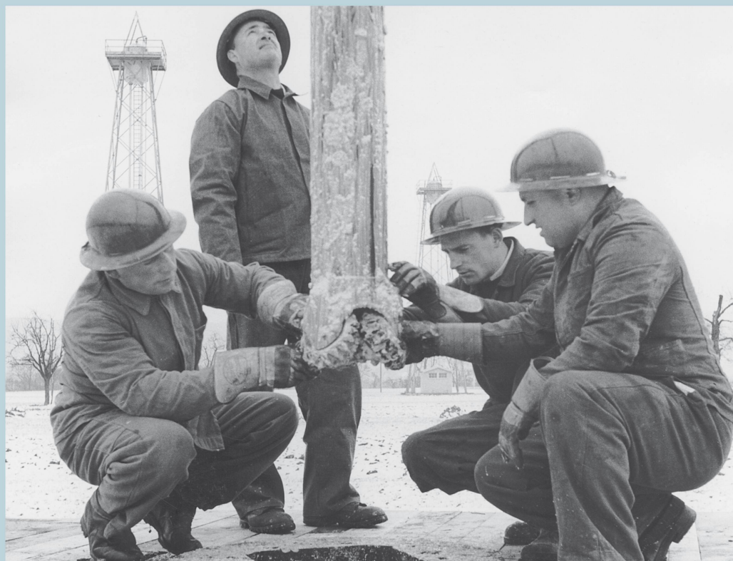
Une équipe de forage lors de l'introduction de la tige à couteaux tournants, 1970.
