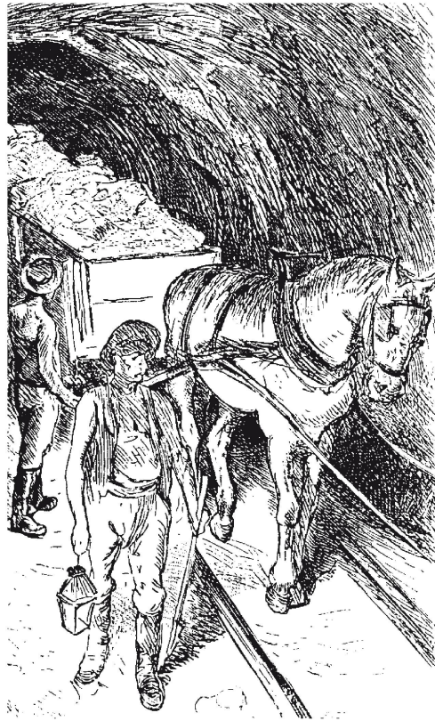
La zone de forte pression de la roche au km 2,8 de Göschenen compliquait l'exploitation. Derrière les étais en bois, seuls davantage de chevaux assuraient l'évacuation des matériaux vers le train de chantier.
