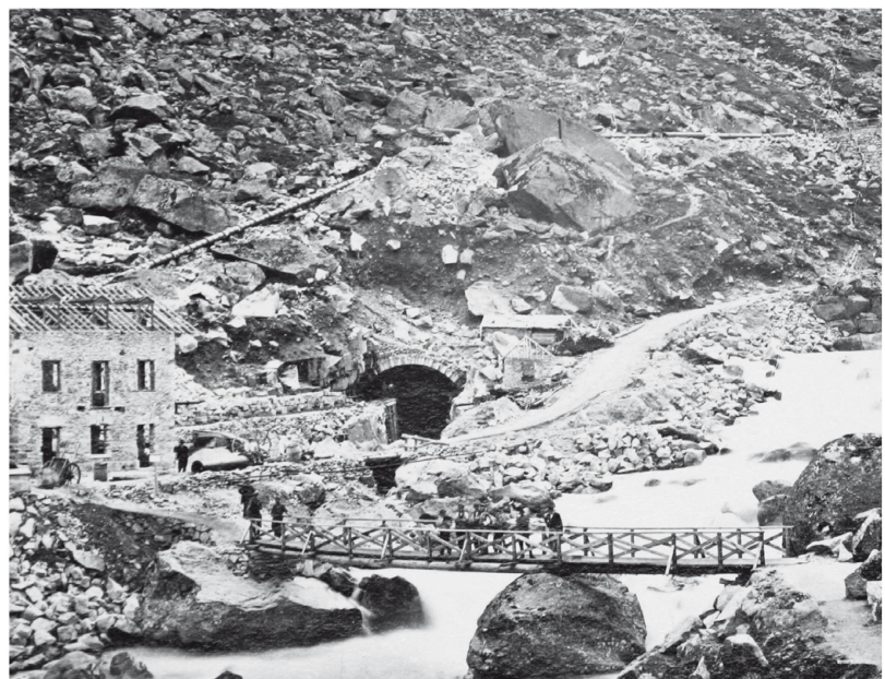
Göschenen: Portail du tunnel et conduite forcée. A gauche, bâtiment administratif en construction. Au premier plan, une passerelle provisoire sur la Reuss.
