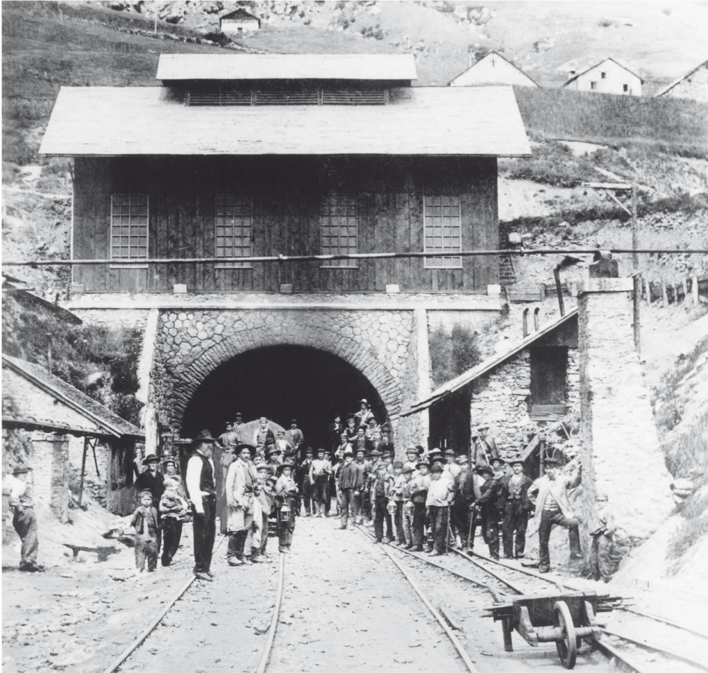
Au-dessus des portails (ici celui de la galerie de fâite à Airolo) des maisons furent installées avec des cloches aspirantes. Lors de pénurie d'eau, les cloches restaient les premières immobilisées.
