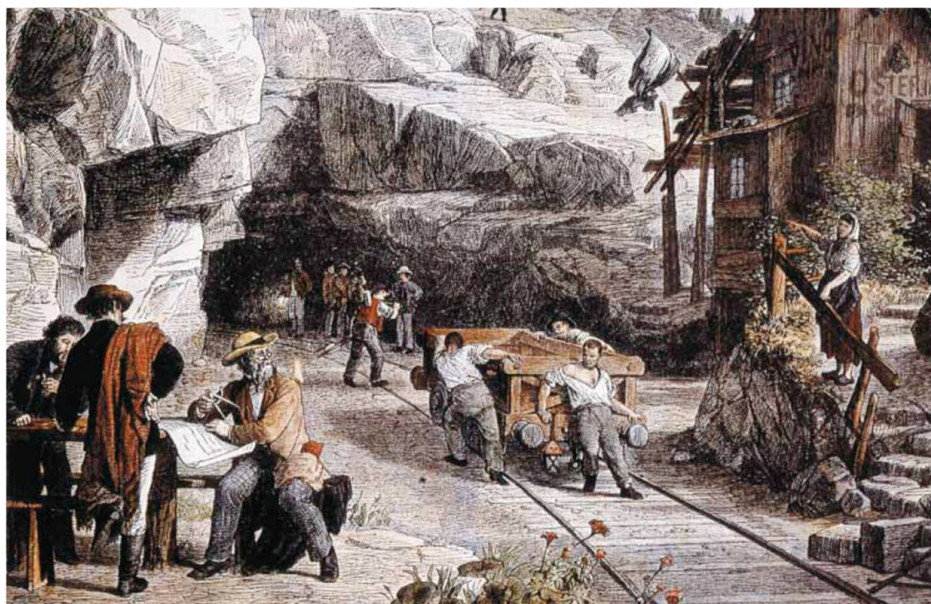
Image idyllique du portail du tunnel de Göschenen, après les premiers coups de pioche. A droite une «Osteria».
