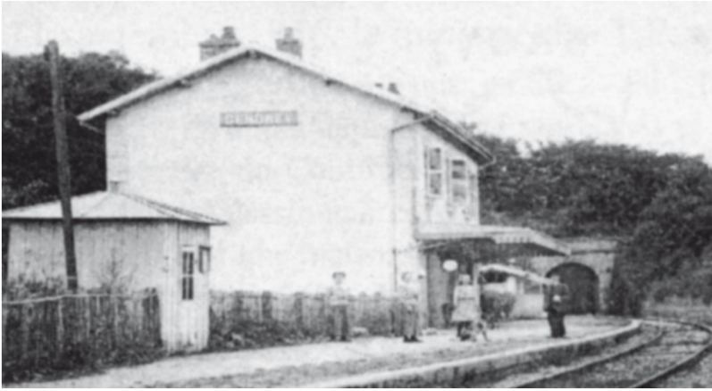
Au sud de la gare de Gendrey, un tunnel de 140 m creusé à travers de la marne.
