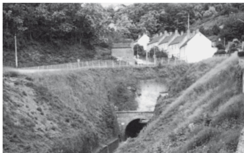
Le plus long tunnel percé par Louis Favre jusqu'en 1872 fut celui du Creusot, long de 934 m et à double voie.
