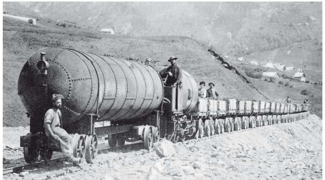
Pose pour le photographe à l'entrée du tunnel à Airolo: train de chantier, à voie métrique, pour l'évacuation des déblais. Locomotive avec tender-réservoir cylindrique à air comprimé en tête, construite par Schneider, Le Creusot.
