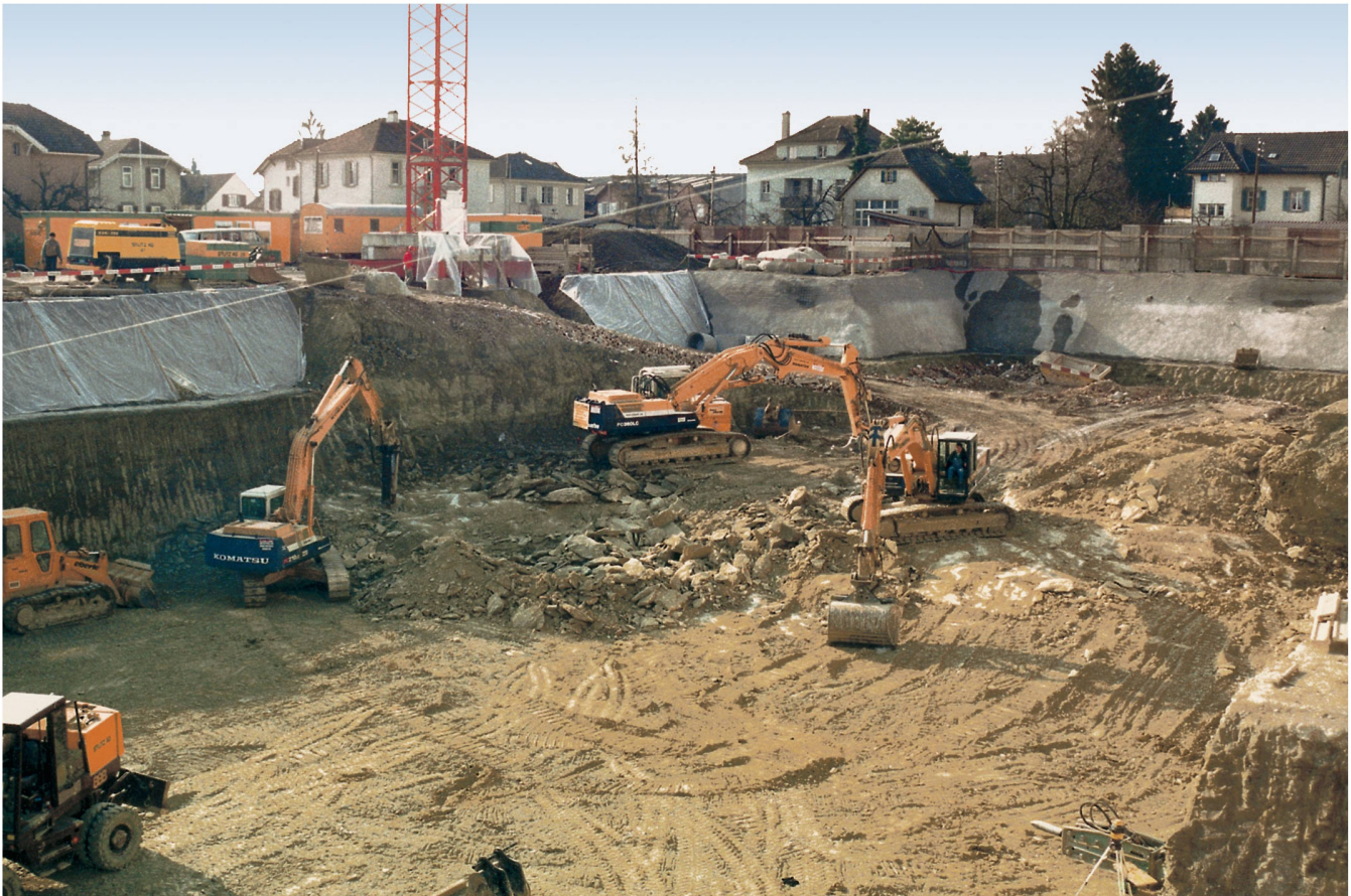
Fouilles de construction pour le nouveau bâtiment de production et le dépôt souterrain
