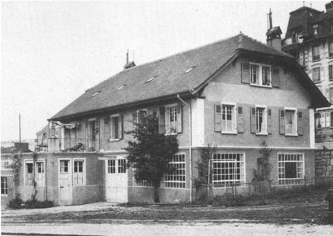
Laboratoire d'hydraulique. Situation initiale
