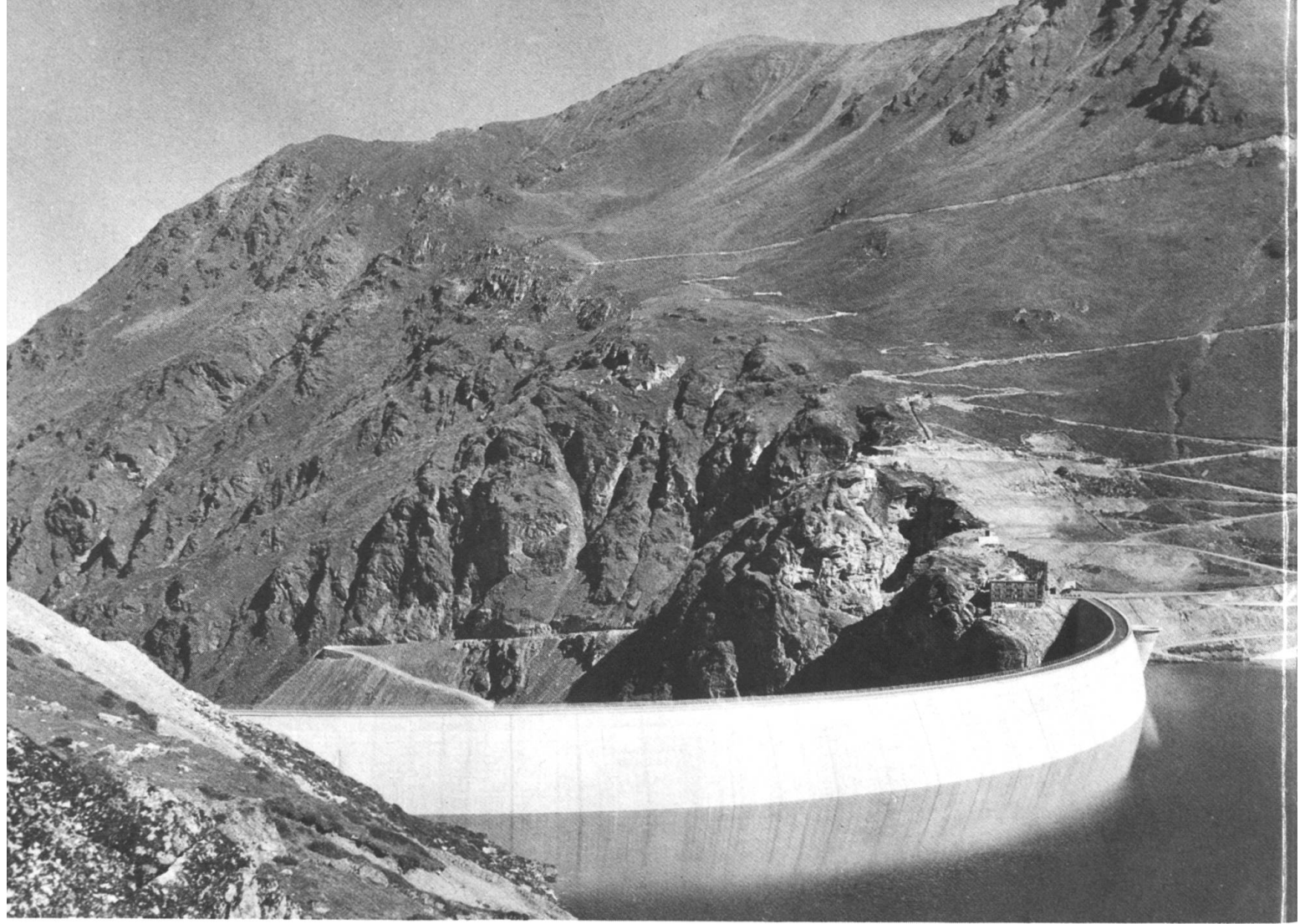
Barrage de Moiry (Photo E. Brügger, Zurich)
