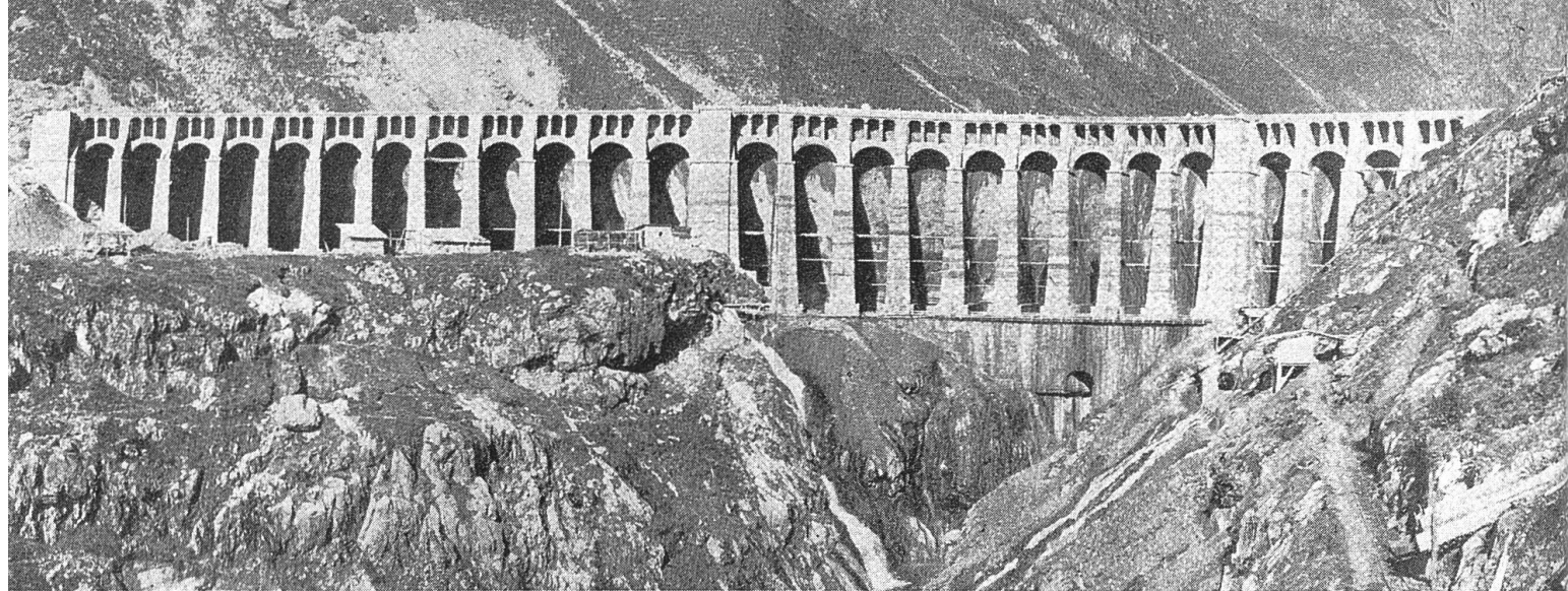
Vue générale du barrage du Gléno, face aval
