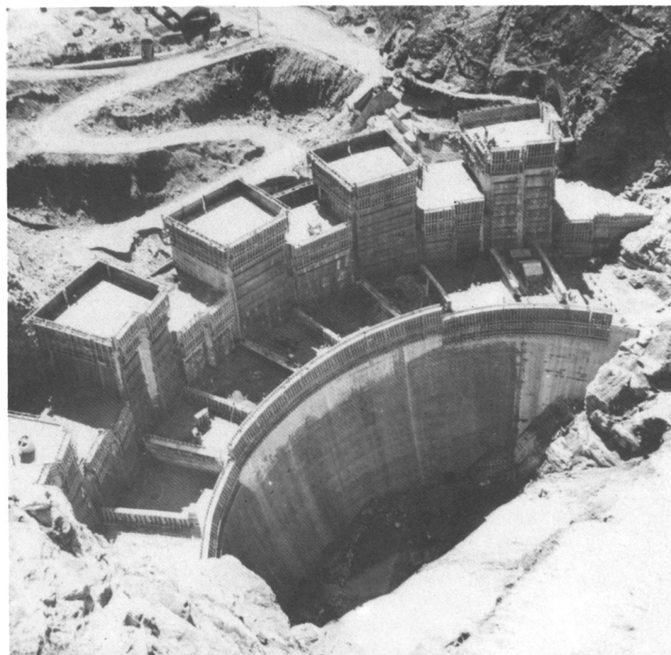
Barrage de Mauvoisin en construction
