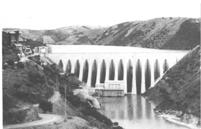
Barrage du Bracana, Portugal
