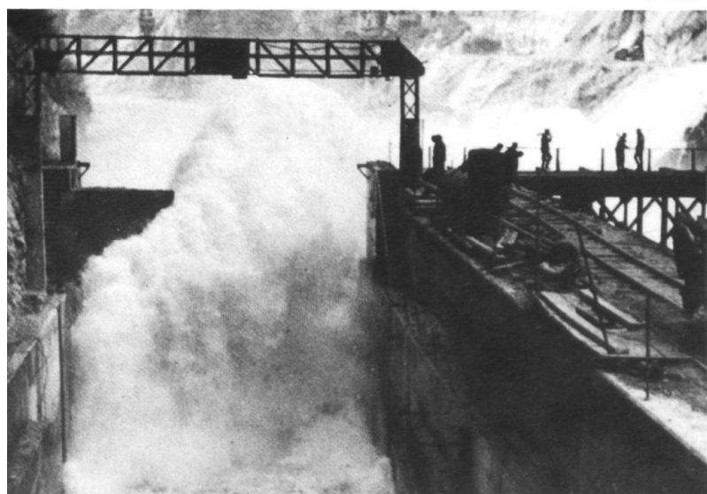
Barrage de Génissiat. Evacuateur de crue, rive gauche, 600 m 3 /sec. 15 mars 1948
