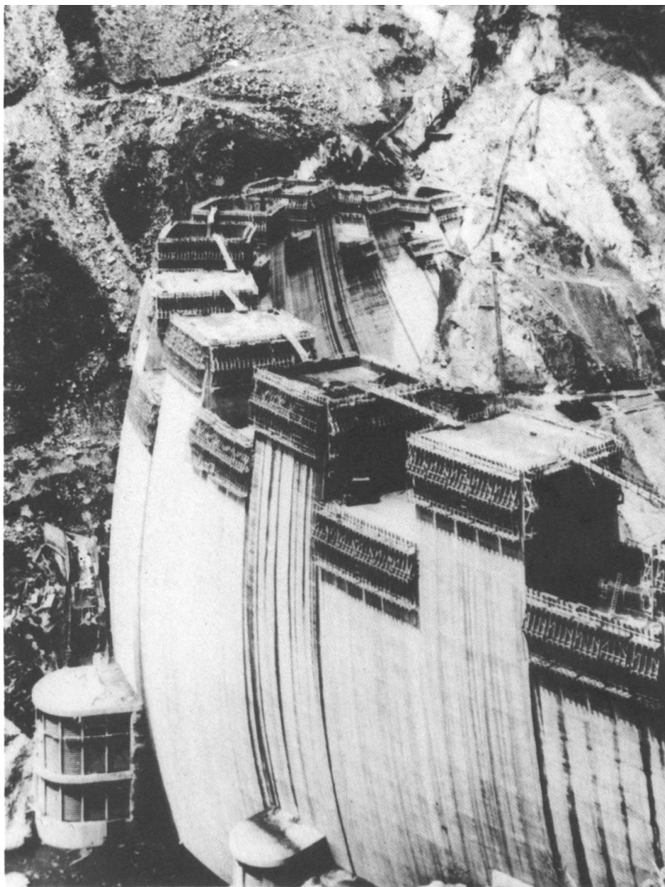
Barrage de Nalps pendant la construction
