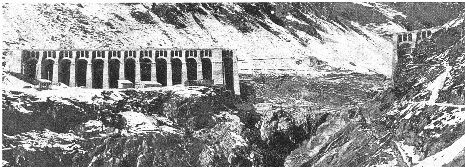
Vue générale du barrage du Gléno après la catastrophe
