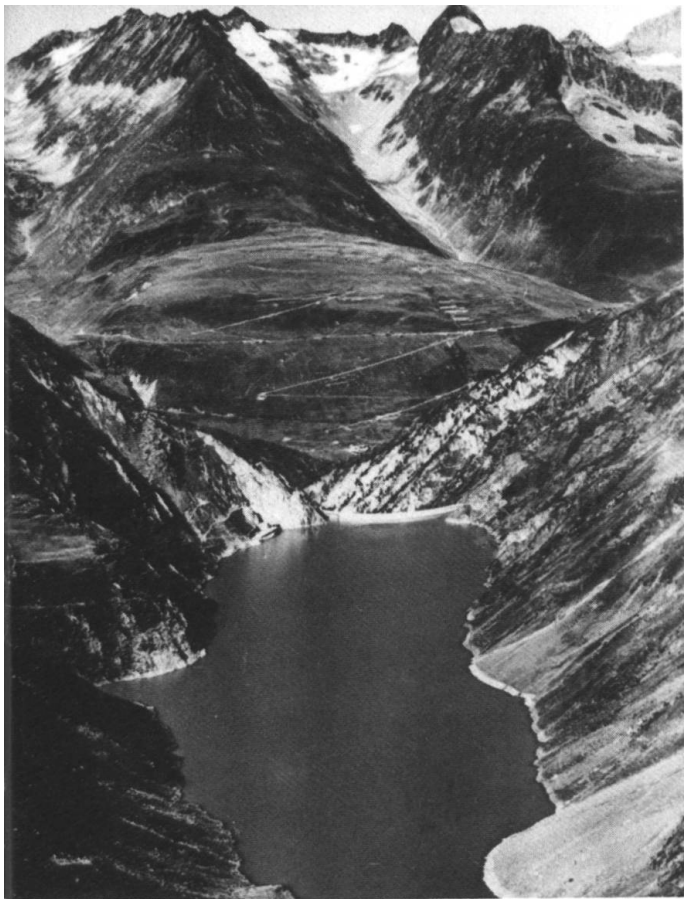
Barrage de Curnera (Photo Comet, Zurich)
