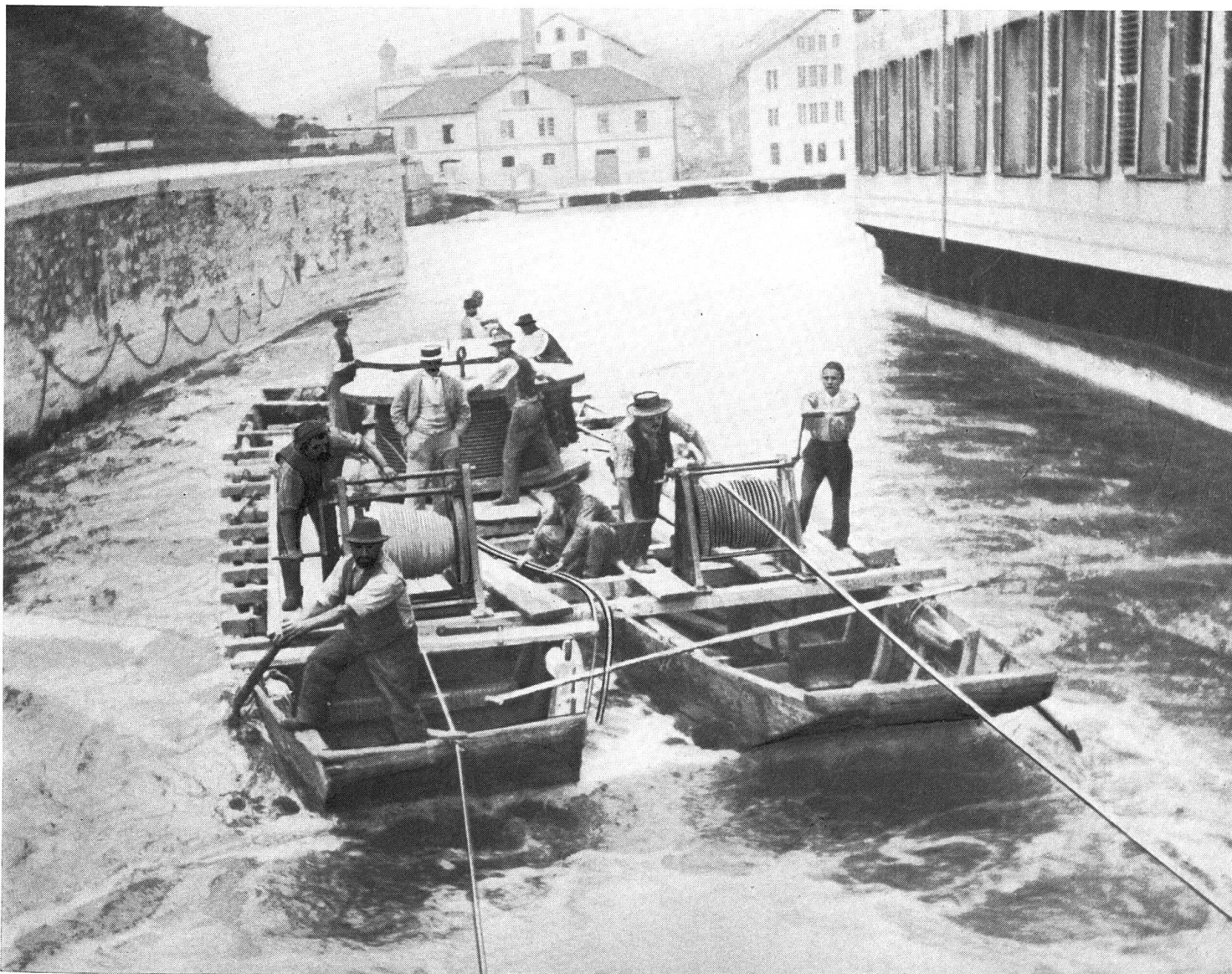
Pose de câbles système Berthoud-Borel, dans la Limmat à Zurich, vers Unterer Mühlesteig, au début du siècle
