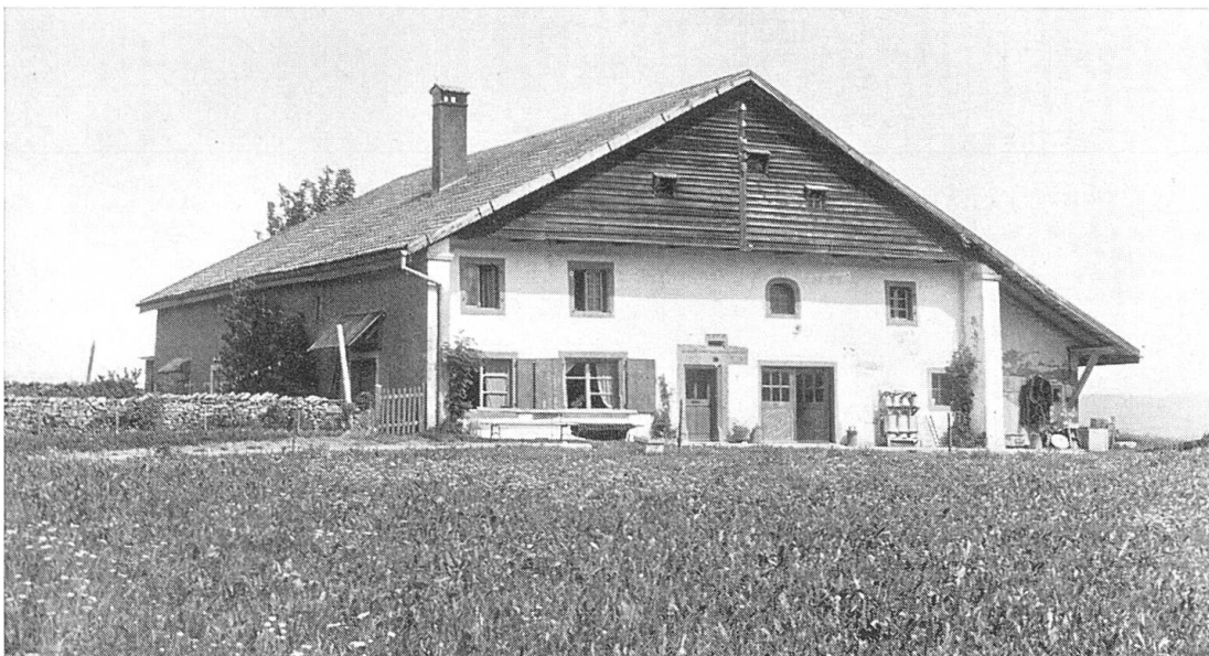
Au-dessus de la porte d'entrée de la maison Nicolet aux Trembles figurent le millésime, l'inscription et les initiales ci-après: «1656. La Sainte Bénédiction de Dieu demeure (éternellement). DIRB» (Daniel Jean-Richard dit Bressel). Au-dessous: la façade ensoleillée et sereine de la vieille ferme familiale.
