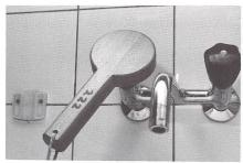
Abb. 5: Wasserhahnengriff – ermöglicht das Öffnen ohne grossen Kraftaufwand und beugt der ungünstigen Ulnardeviation vor.
