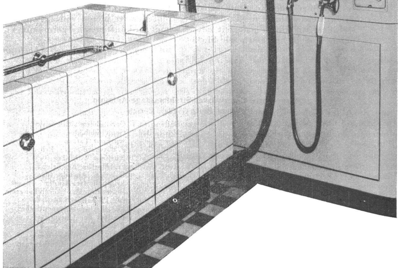
**Technische Handhabung:** Einstellung der Zirkulationsmenge. - Ablesung des Applikationsdruckes an Präzisions-Manometer. - Einstellung der Strahltemperatur durch Beimischung von Heisswasser. - Ablesung der Strahltemperatur an sofort anzeigendem Thermometer. Beimischung von Luft zur Regulierung der Strahl-Vibration. - Kühlung zur Konstanthaltung der Wannenwassertemperatur. - Auswechselbare Düsen. - Betriebsschalter mit Automat und Sicherungen.
