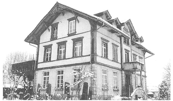
Abb. 10: Thierachern, Sekundarschulhaus. Im Erdgeschoss befanden sich ursprünglich zwei Schulzimmer, im Obergeschoss zwei kleine Wohnungen. Im Giebel über dem Eingang war eine Uhr vorgesehen. Aufnahme 2000. (E.S.)
