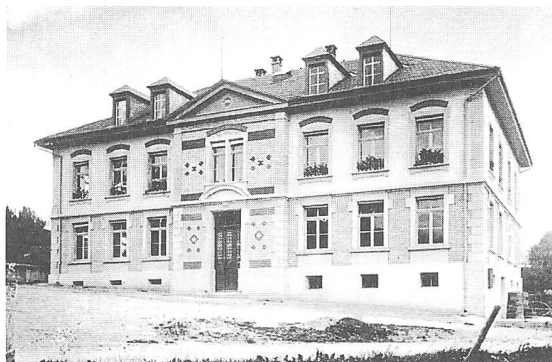
Abb. 5: Oberbalm, Primarschulhaus. Hauptfassade, kurz nach der Fertigstellung. Aufnahme um 1900. (Ernst Selhofer)
