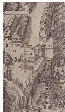
Fig. 66 Martin Martini, le haut de la rue de Lausanne fermé par la tour des prisons (66) et la porte du Jaquemart, avec hors-les-murs la halle au vin (19), la place «welsche» (65) et la chapelle Saint-Maur (P) puis, intra-muros, l'auberge de la Cigogne (44) acquise en 1638 par les Ursulines. Les légendes imprimées après cette date ont été adaptées et portent, au numéro 59, la mention: «Aux Ursulines et la porte du Jaquemart», cet ouvrage étant par ailleurs désigné par deux numéros correspondant à ses deux fonctions (SBC).
