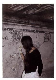
Fig. 160 Work in progress : retouches et consolidations de l'enduit et du décor de 1711-1712 après dégagement et avant compléments.
