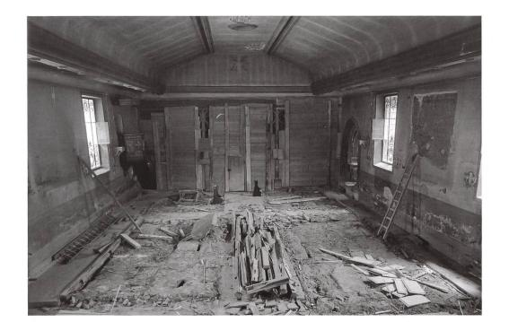
Fig. 79 Photo de chantier en 1951, après suppression des bancs, des dalles funéraires et du chauffage de la nef, peu avant l'enlèvement de la chaire du XVII<sup>e</sup> s. et la démolition du plafond en staff de 1885-1886.
