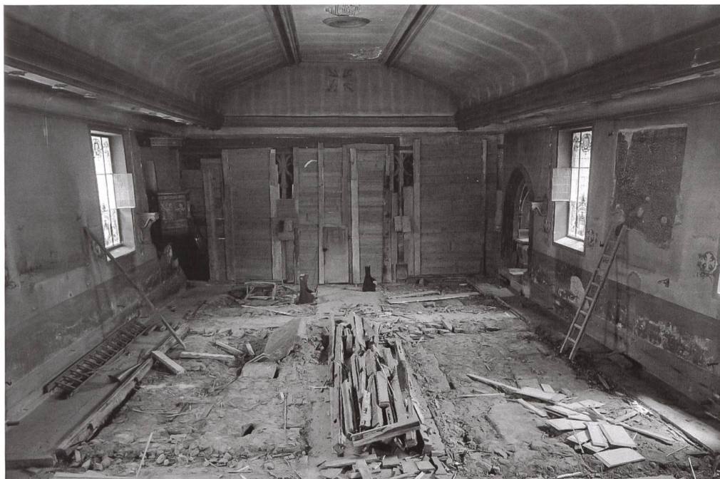
Fig. 79 Photo de chantier en 1951, après suppression des bancs, des dalles funéraires et du chauffage de la nef, peu avant l'enlèvement de la chaire du XVII e s. et la démolition du plafond en staff de 1885-1886.
