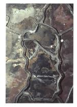
Abb. 161 Schmutzablagerungen und Korrosionsprodukte auf der Aussenseite des Fensters der Heiligen Petrus und Laurentius (Detail).
