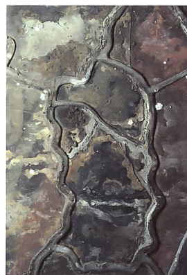
Abb. 161 Schmutzablagerungen und Korrosionsprodukte auf der Aussenseite des Fensters der Heiligen Petrus und Laurentius (Detail).
