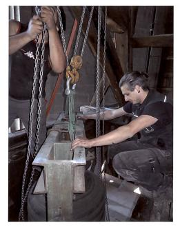
Abb. 131 Die Stundenglocke von 1416 im oberen Glockenstuhl, noch mit dem Stahljoch, wird sorgfältig abgehängt.
