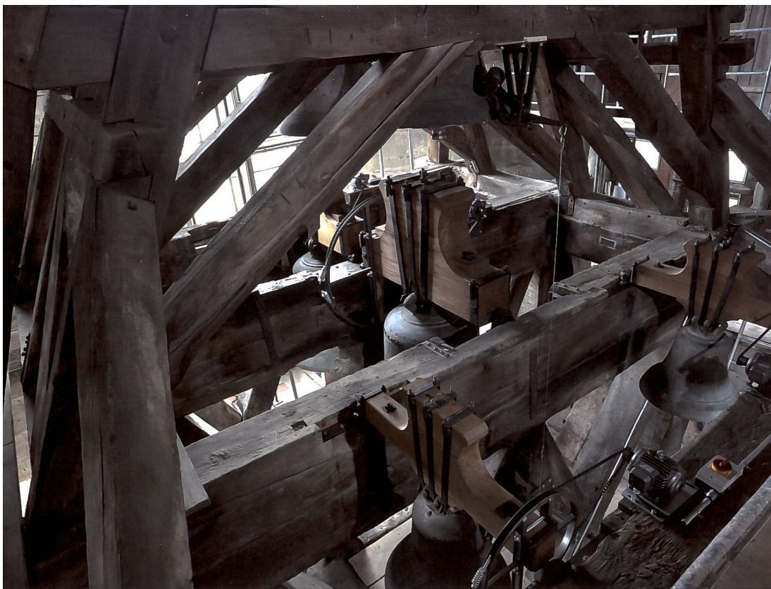
Abb. 134 Blick in den oberen Glockenstuhl von 1480 mit dem 1547 aufgesetzten zusätzlichen Geschoss.
