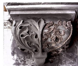
Abb. 104 Neugotische Konsole während der Restaurierung 2016. Rechts die erste Schicht der Aufmodellierung, links abgeschlossene Aufmodellierung.
