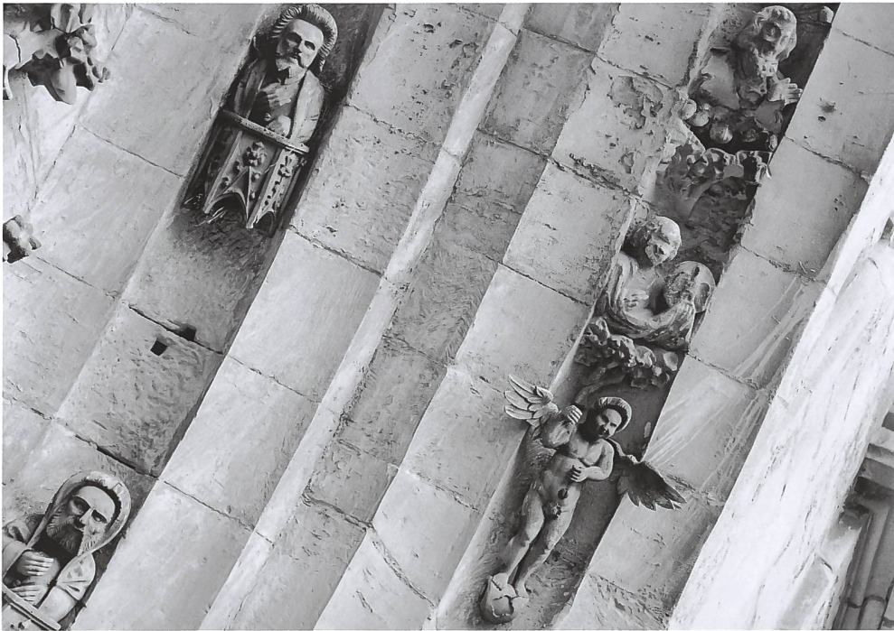
Abb. 98 Detail der Archivolten, um 1950. Wegen Schäden durch von oben eindringende Feuchtigkeit wurden gewisse Figuren bereits im späten 16. Jahrhundert durch solche aus Holz ersetzt. Die beiden Propheten links und der Engel rechts sind solche Neuschöpfungen.
