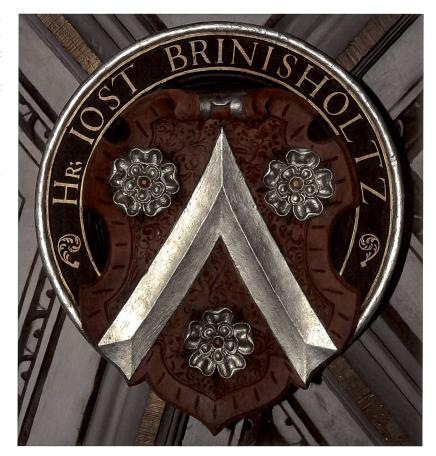
simple et efficace (fig. 89). Des cales épaisses à base de mortier de chaux sont appliquées au dos de chaque médaillon pour le caler et en régler l'orientation. La radiographie d'un de ces médaillons a révélé une étonnante armature métallique prise dans la masse, assurant l'anneau
