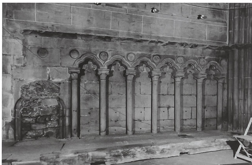
Fig. 74 Arcature aveugle au bas du mur sud du chœur, datant de la première phase de construction, vers 1283-1300, aujourd'hui masquée par les stalles, avec l'entrée condamnée de la sacristie à l'extrémité est.
