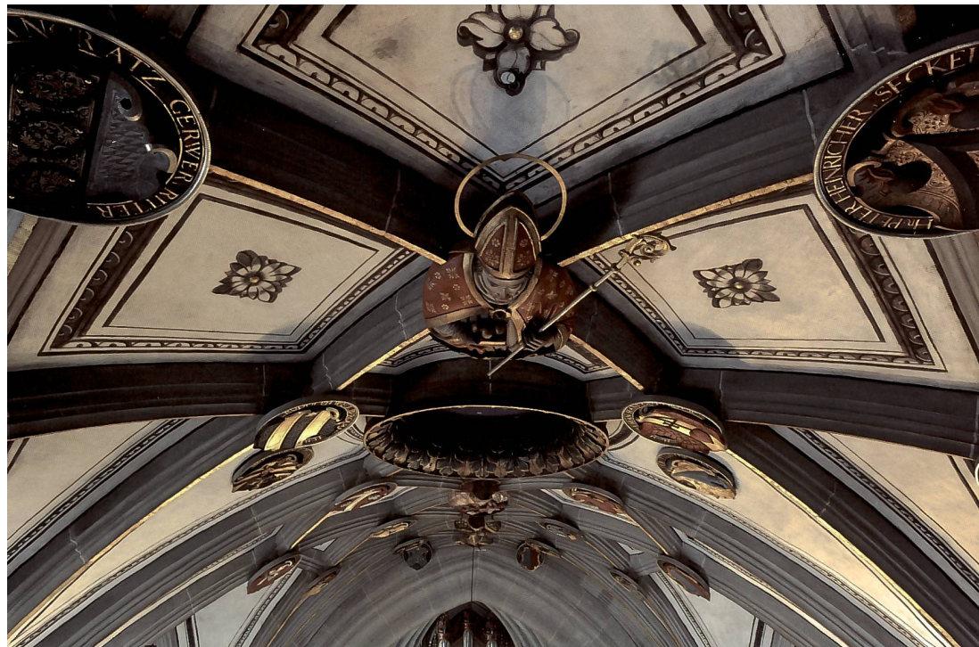
Fig. 77 Vue rasante de la voûte du chœur vers la nef, avec l'effigie de saint Nicolas de Myre devant la clef annulaire «passe-image» entourées des médaillons héraldiques aux armes des autorités en place.
