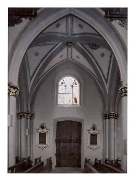
Abb. 66 Nordportal, Innenseite. Die Aussenmauer in ihrer ursprünglichen Position und die Pfeiler samt innersten Diensten und Kapitellen sind erhalten; schmaler Schildbogen am Übergang zum Gewölbe. Die Asymmetrie der Türflügel spiegelt die aufwändigere Gestaltung des Äussern von 1761-63.
