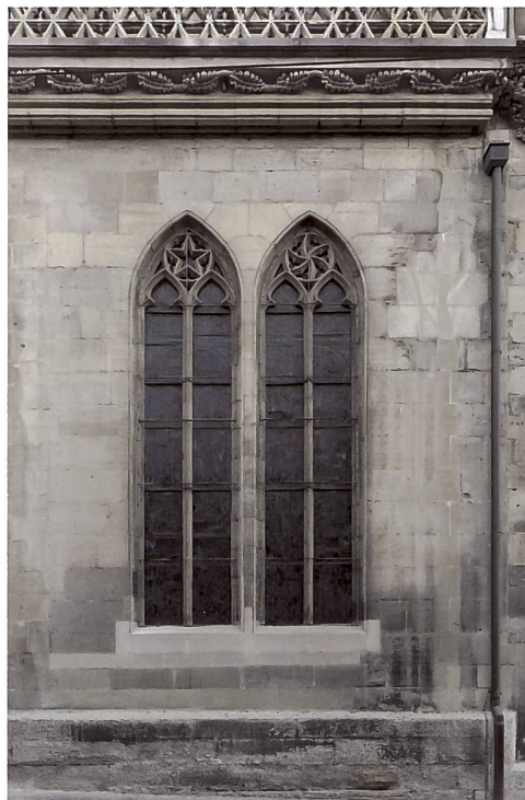
Abb. 68 Südfassade, Ölbergkapelle, vor der Restaurierung. Die Fenster wurden im 19. Jahrhundert nach unten und vermutlich nach oben verlängert und mit neuem Mittelpfosten und Masswerk versehen. Rechts die grosse Sakristei von 1632. Gebälk, Brüstung und Konsolenfigur neugotisch.
