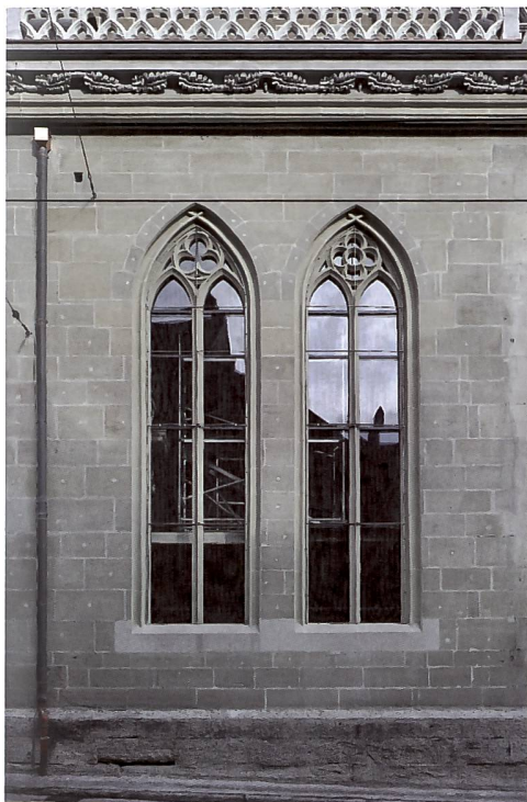
Abb. 67 Südfassade, Votivkapelle Unserer Lieben Frau vom Siege während der Restaurierung, nach Entfernen des Gerüsts. Das Mauerwerk der Kapelle greift vor die Stirnseiten der Strebepfeiler und stösst rechts an die Fassade der Ölbergkapelle. Die Schutzverglasung ist bereit, im Innern die Glasgemälde aufzunehmen.
