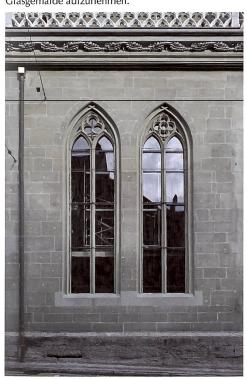
Abb. 68 Südfassade, Ölbergkapelle, vor der Restaurierung. Die Fenster wurden im 19. Jahrhundert nach unten und vermutlich nach oben verlängert und mit neuem Mittelpfosten und Masswerk versehen. Rechts die grosse Sakristei von 1632. Gebälk, Brüstung und Konsolenfigur neugotisch.
