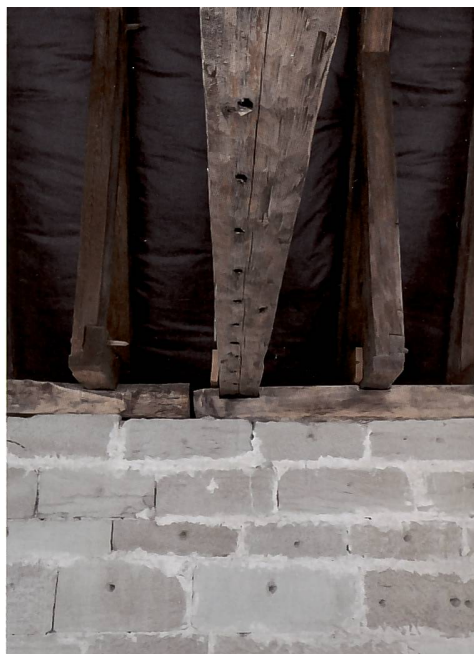
Abb. 52 Westlicher Zerrbalken des Dachwerkabschnitts von 1350-51 (Bundachse 5), Stakenlöcher an der Balkenunterseite bezeugen eine provisorische Abschlusswand.
