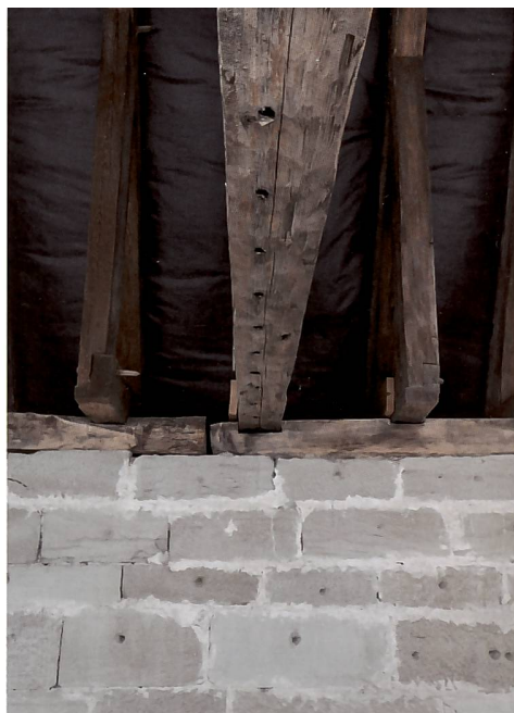
Abb. 52 Westlicher Zerrbalken des Dachwerkabschnitts von 1350-51 (Bundachse 5), Stakenlöcher an der Balkenunterseite bezeugen eine provisorische Abschlusswand.
