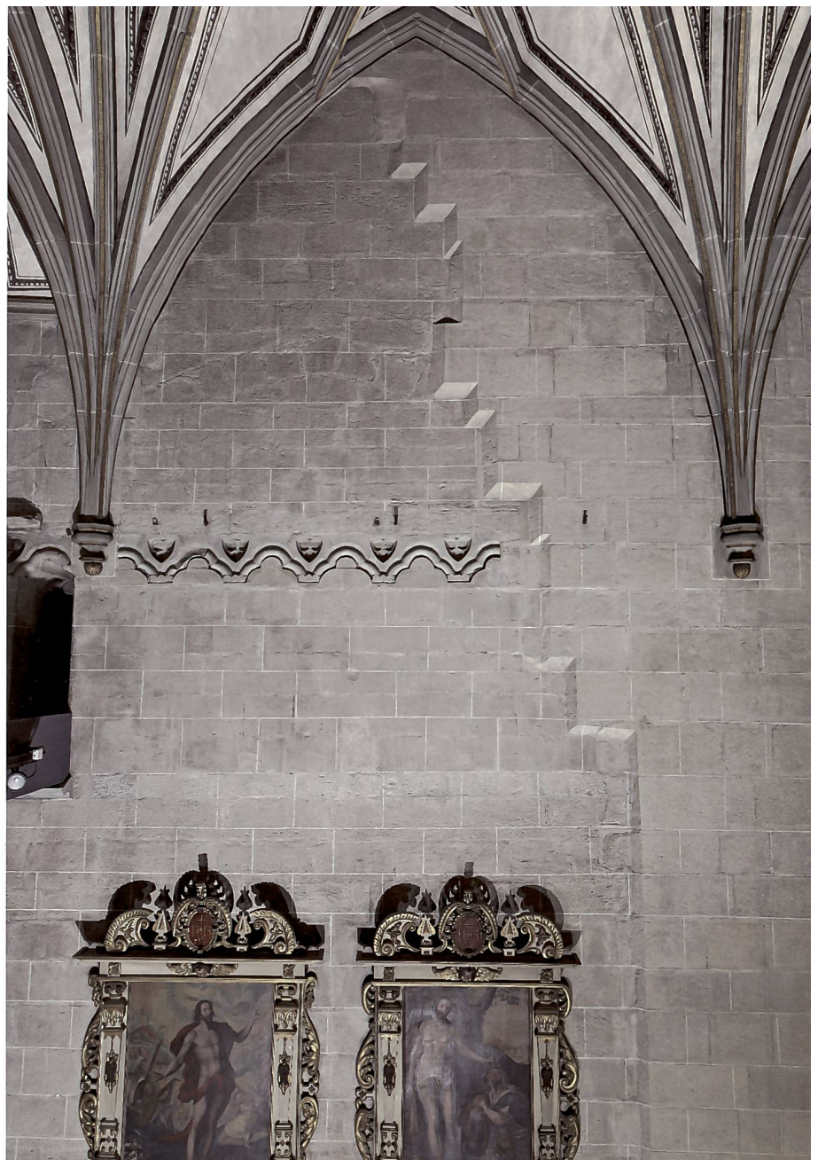
Abb. 55 Chor, Nordmauer, erhaltene Partie des gotischen Mauerwerks mit Resten des geschlossenen Triforiums. Erkennbar sind der Entlastungsbogen darüber sowie die Spur des abgeschlagenen Gesimses des Laufgangs. Mauerwerk rechts und Gewölbe von 1630.
