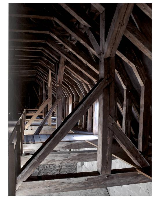
Abb. 48 Dachwerk von 1350-51, Ansicht der Südseite vor Bundachse 8.
