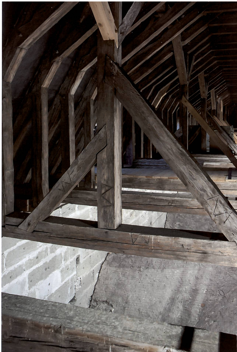
Abb. 51 Dachwerk von 1350-51, Abbundzeichen auf Zerrbalken, Stuhlsäule und Fussstreben des Gespärres 19, Bundachse 5, vgl. Abb. 50.
