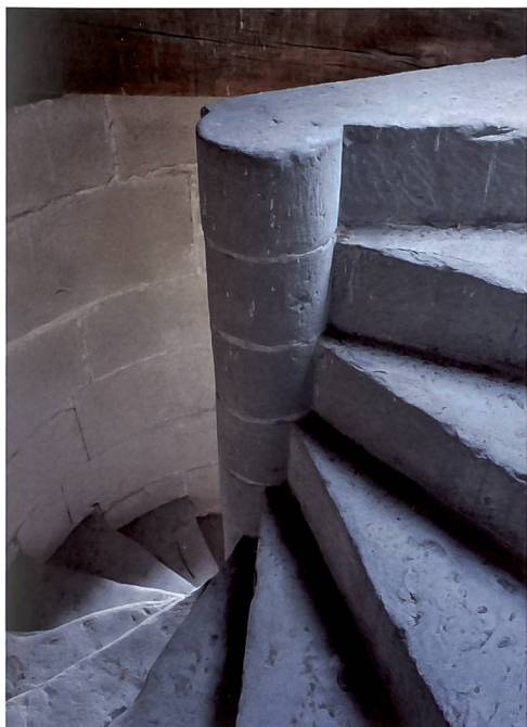
Abb. 54 Chorschulter der Nordseite, bis auf die Höhe des Triforiums abgebrochene Wendeltreppe zum abgegangenen gotischen Chorturm.
