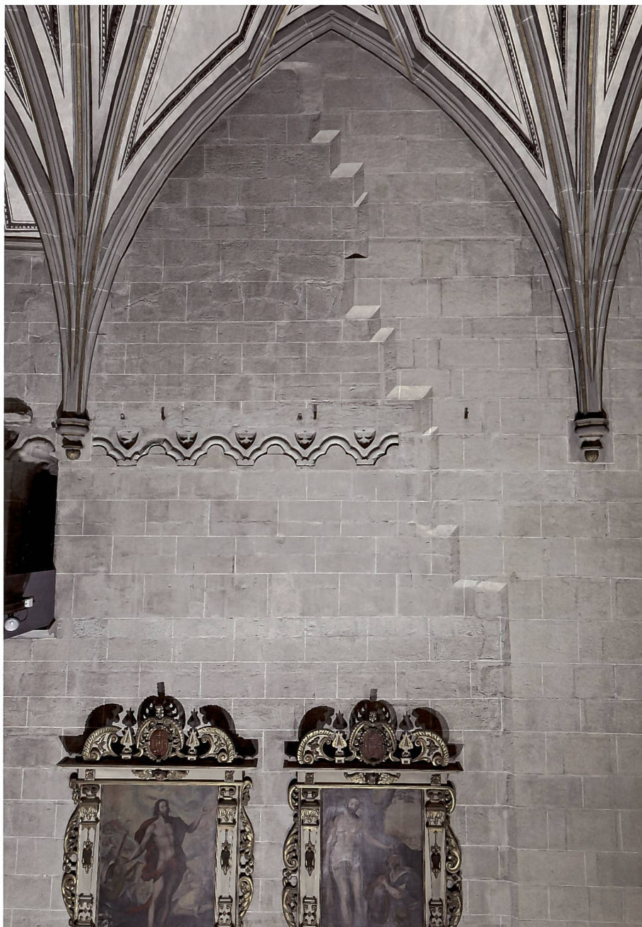
Abb. 55 Chor, Nordmuer, erhaltene Partie des gotischen Mauerwerks mit Resten des geschlossenen Triforiums. Erkennbar sind der Entlastungsbogen darüber sowie die Spur des abgeschlagenen Gesimses des Laufgangs. Mauerwerk rechts und Gewölbe von 1630.
