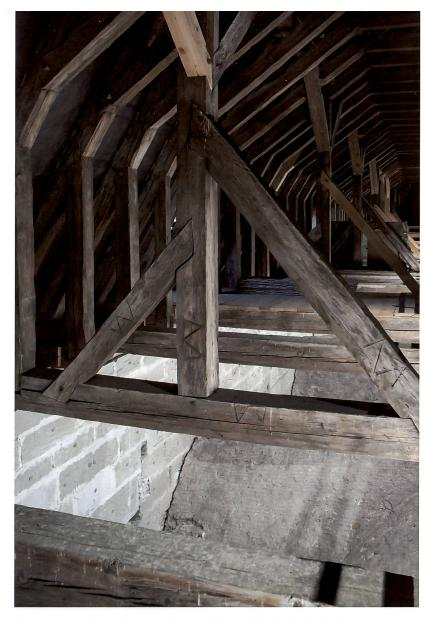
Abb. 51 Dachwerk von 1350-51, Abbundzeichen auf Zerrbalken, Stuhlsäule und Fussstreben des Gespärres 19, Bundachse 5, vgl. Abb. 50.
