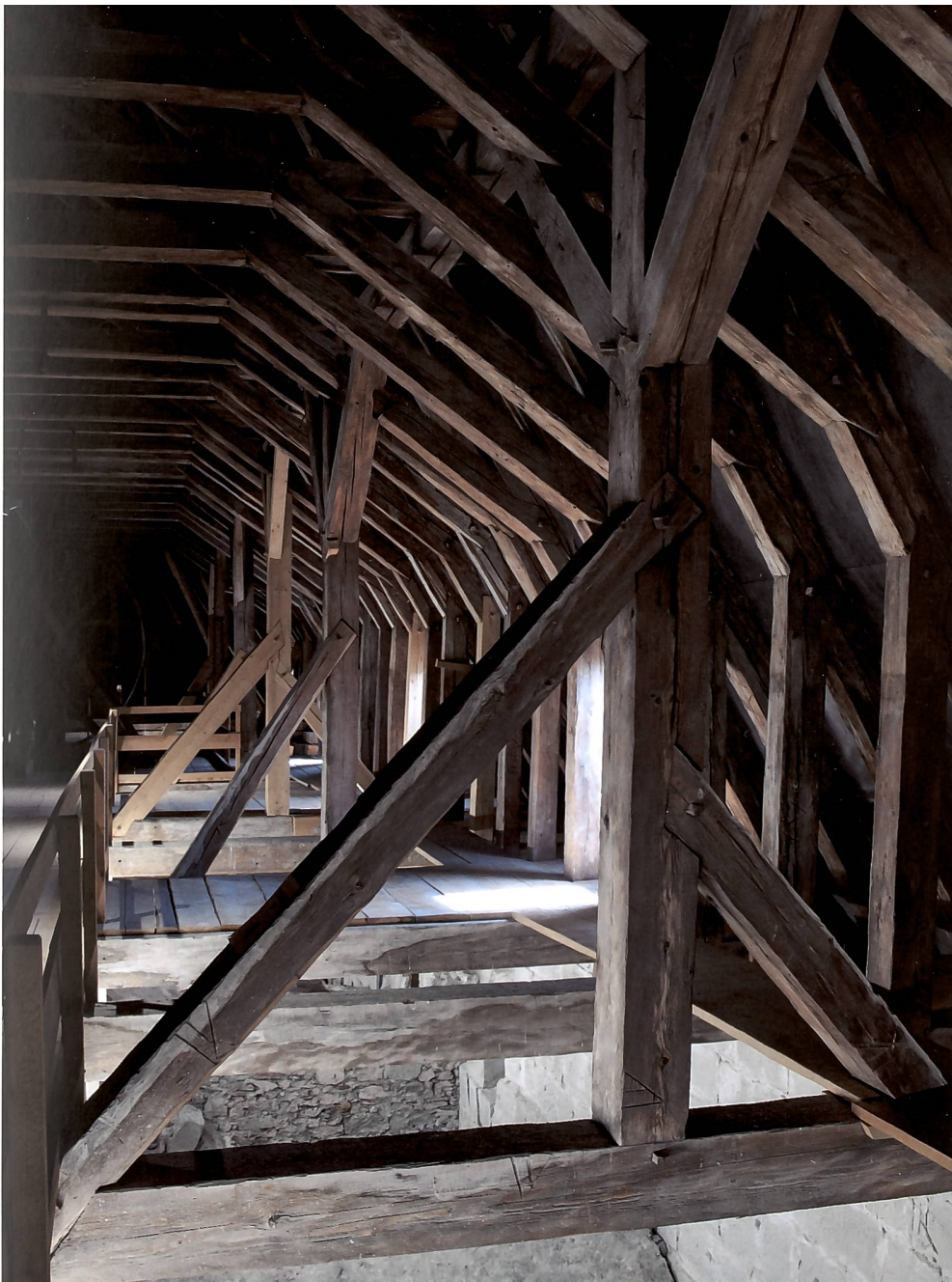
Abb. 48 Dachwerk von 1350-51, Ansicht der Südseite vor Bundachse 8.
