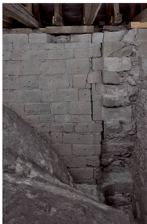
Abb. 57 Befund zwischen Gewölbe und Dachwerk, Baunaht zwischen Chor und Obergaden auf der Nordseite, in der Mitte Ausbruch der Westmauer des Chorturms, links anschliessend Obergaden, unten und rechts erneueter Chorbogen und Mauer von 1630.
