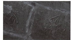
Abb. 39 Die aus sphärischen Dreiecken gebildeten Trompen stellen hohe Anforderungen an den Steinschnitt und den Versatz. Daher die zahlreichen und mehnteiligen Versatzzeichen.
