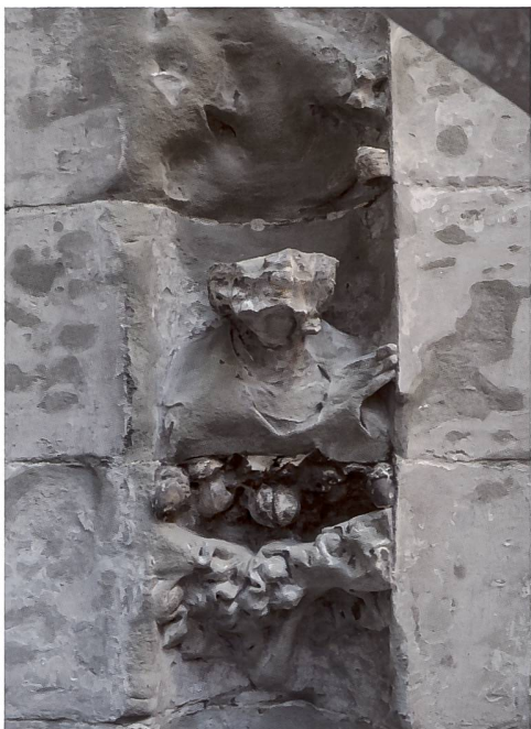
Fig. 8 Portail sud, détail d'une voussure avant remodelage de la tête d'un prophète.
