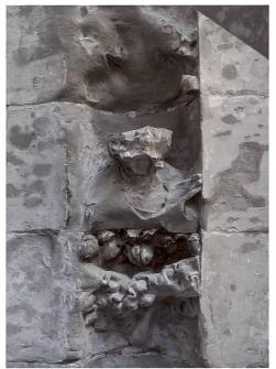
Fig. 9 Portail sud, détail d'une voussure avec tête de prophète en cours de remodelage, 2015.
