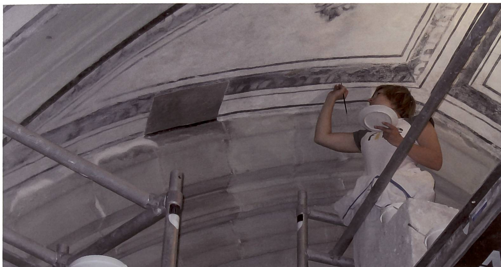
Fig. 7 Retouches au décor du XVII e siècle dans le collatéral sud avec maintien d'un témoin de l'état avant intervention.
