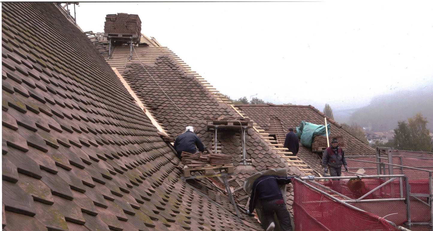
Fig. 131 Travaux de couverture et de ferblanterie après la pose de l'isolation sur chevrons ayant nécessité de découvrir un toit en parfait état puisque refait avant le début du chantier.
