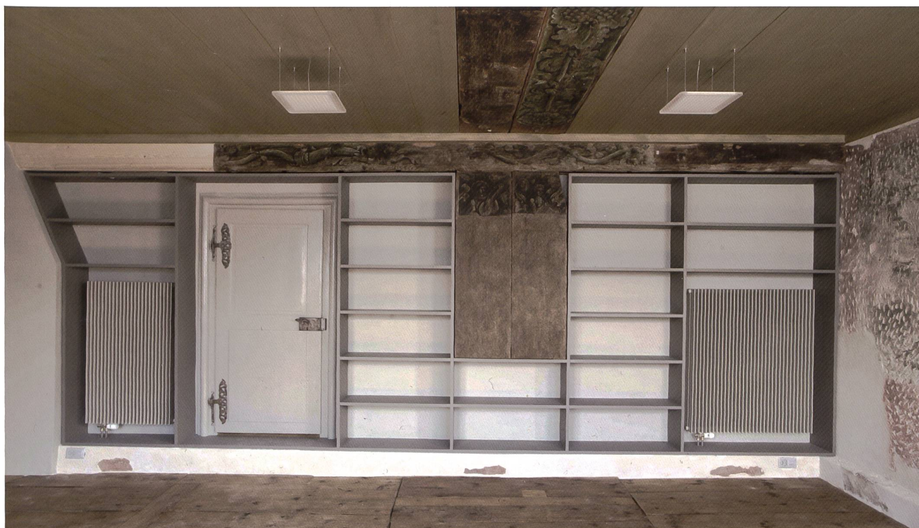
Fig. 129 Le processus d'intégration illustré dans la «chambre verte» du 2 e étage. En guise de 4 e paroi, une bibliothèque, deux madriers peints du XVI e s. et le radiateur sont posés sur la semelle du mur d'origine dont ils restituent la profondeur dans un nouvel ensemble intégrant plusieurs fonctions. Le décor, élément majeur de cette pièce, retrouve ainsi son cadre architectural.
