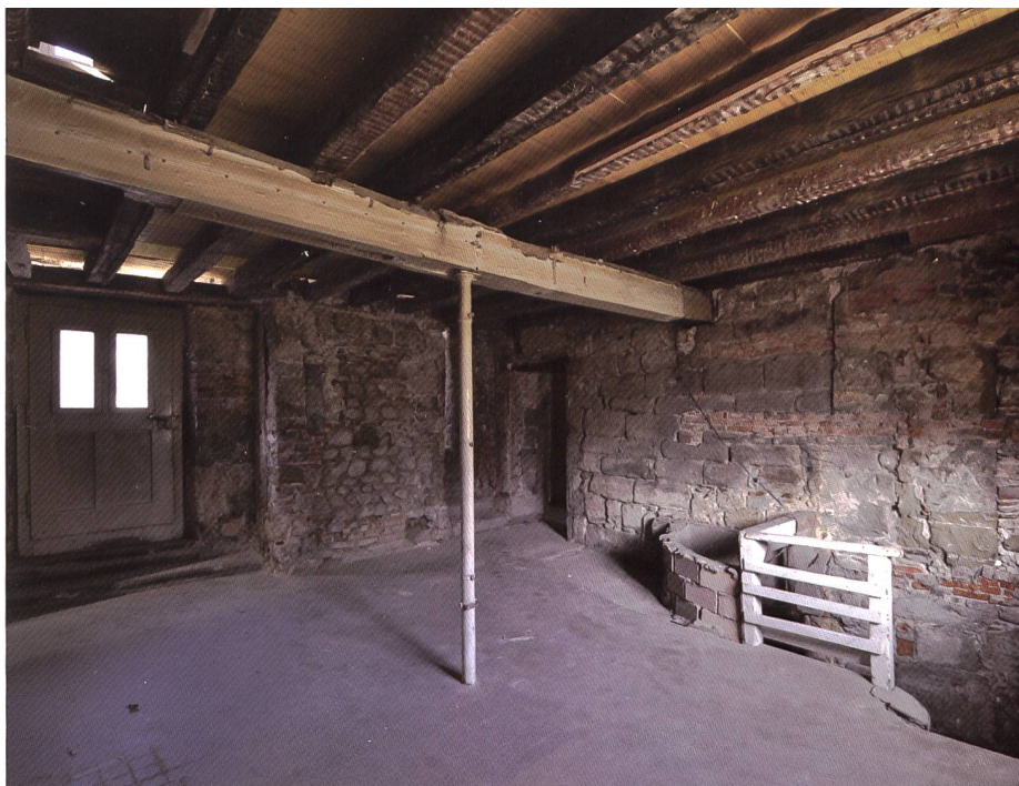
Fig. 22 L'annexe sud de la commanderie en cours d'analyse, avec la poutraison de la cuisine au rez-de-chaussée: les solives foncées remontent à 1473/74 et le sommier à 1521/22.
