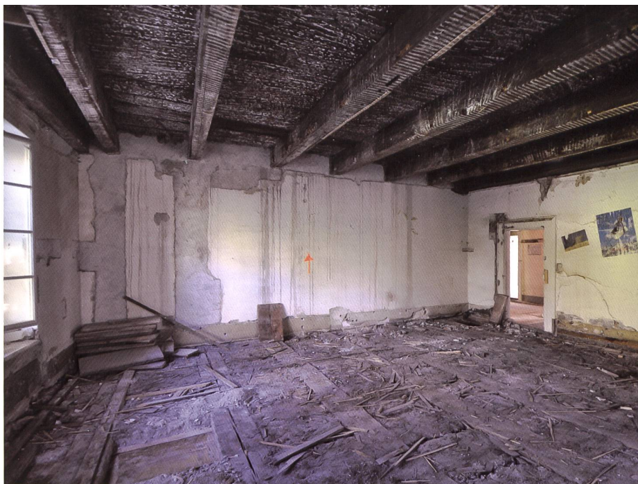
Fig. 19 La grande salle orientale du 1 er étage, en cours d'analyse, avec sa poutraison d'origine constituée de bois abattus durant l'automne/hiver 1304/05.
