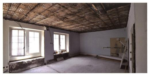
Fig. 24 La grande salle sud-ouest du 1<sup>er</sup> étage en cours d'analyse, avec plafond à madriers jointifs fait de bois abattus durant l'automne/hiver 1343/44, permettant de dater l'agrandissement ouest de la commanderie. Il s'agit en outre du plus ancien plafond de ce type repéré dans le canton.
