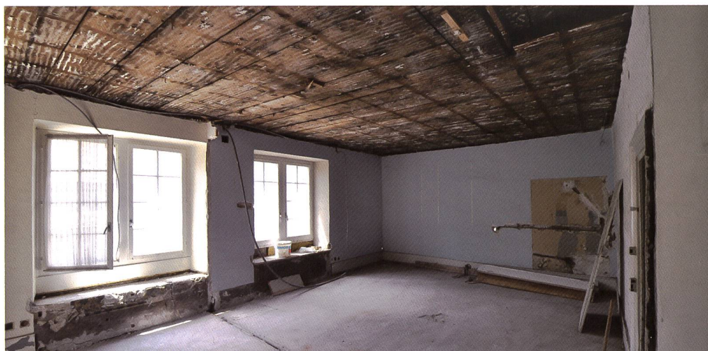
Fig. 24 La grande salle sud-ouest du 1 er étage en cours d'analyse, avec plafond à madriers jointifs fait de bois abattus durant l'automne/hiver 1343/44, permettant de dater l'agrandissement ouest de la commanderie. Il s'agit en outre du plus ancien plafond de ce type repéré dans le canton.
