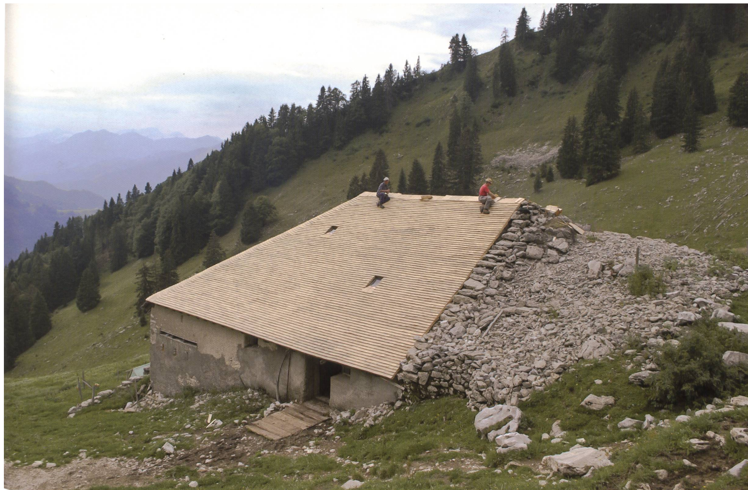
Fig. 5 Vue de l'arrière du chalet de la Grande Ecosalla avec son talus pare-avalanche permettant aux coulées de neige de glisser le long des pans.
