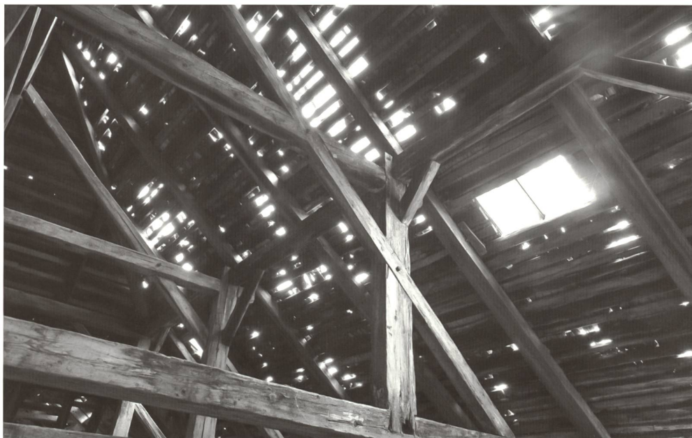
Fig. 13 Détail de la charpente et état de la couverture actuellement bâchée, suite à l'orage de grêle du 23 juillet 2009.
